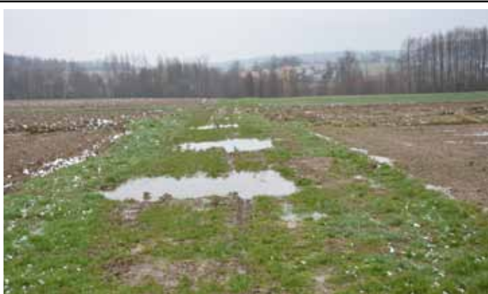
Droga gminna przed modernizacją
