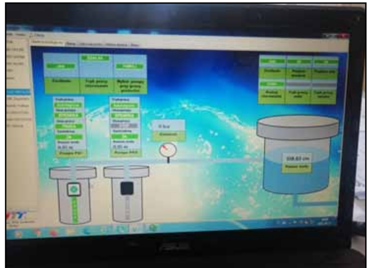
Monitoring pracy studni na ujęciu wody i współpracy ze zbiornikiem.
