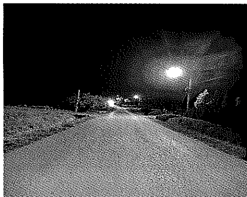
Zdj. Nowe oświetlenie uliczne
