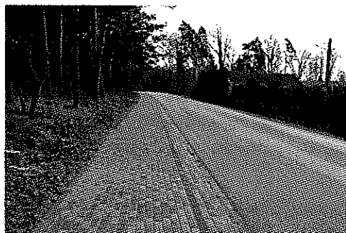
Zdj. Droga powiatowa w Laszczynach
