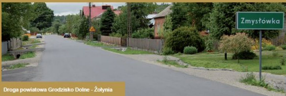
Droga powiatowa Grodzisko Dolne - Żołyńia
